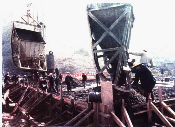
1988年12月13日大坝开始浇筑第一仓混凝土
