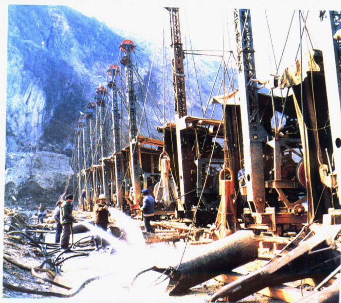
下游围堰防渗墙施工
