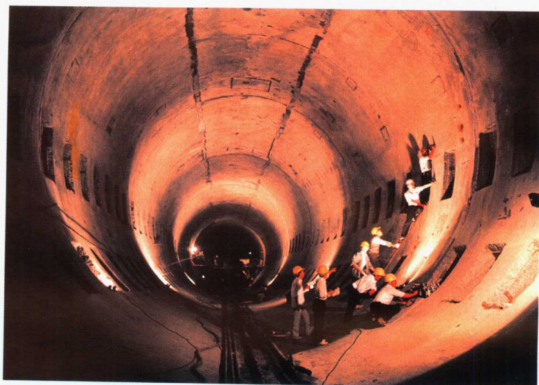
引水洞环向预应力 混凝土施工
