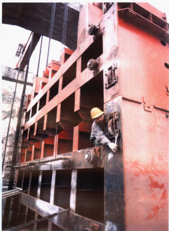
大坝闸门及金属结构安装
