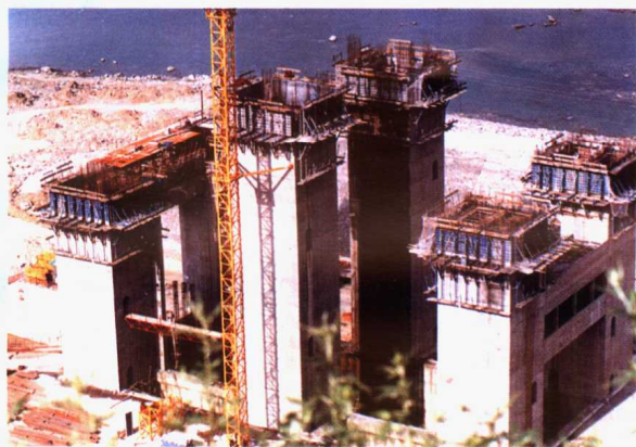
垂直升船机混凝土浇筑
