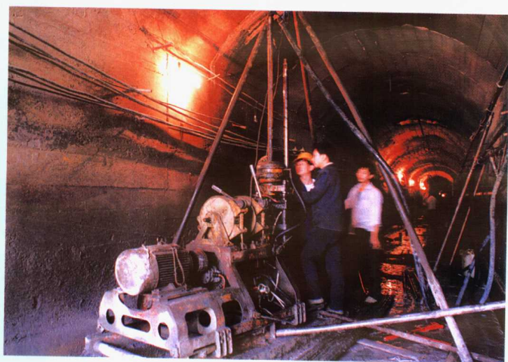
大坝帷幕灌浆施工
