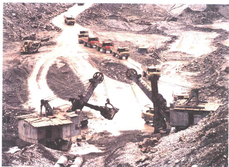
1988年1月1日大坝基坑开始开挖
