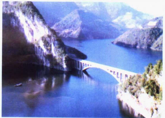
库区交通道路重建
