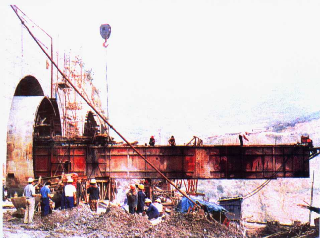
应用钢模台车进行引水洞混凝土浇筑
