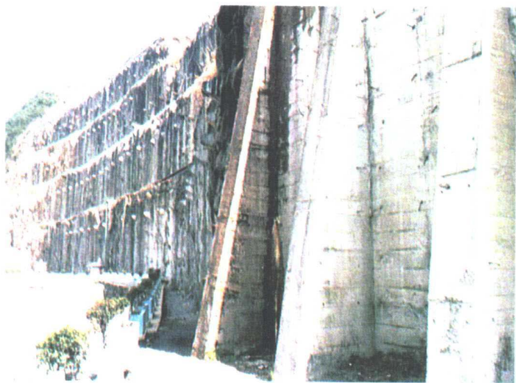
电站厂房及高边坡施工
