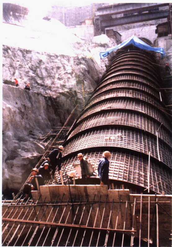
压力钢管安装
