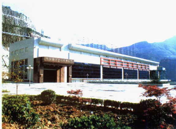
隔河岩水电站厂房外景
