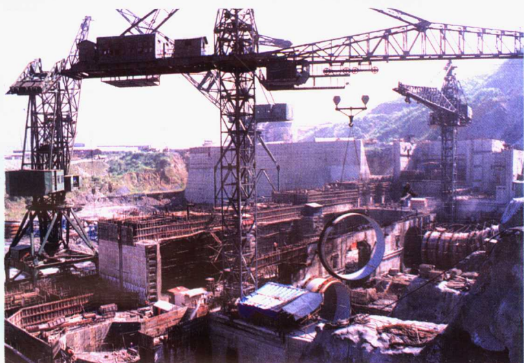
水电站厂房混凝土浇筑
