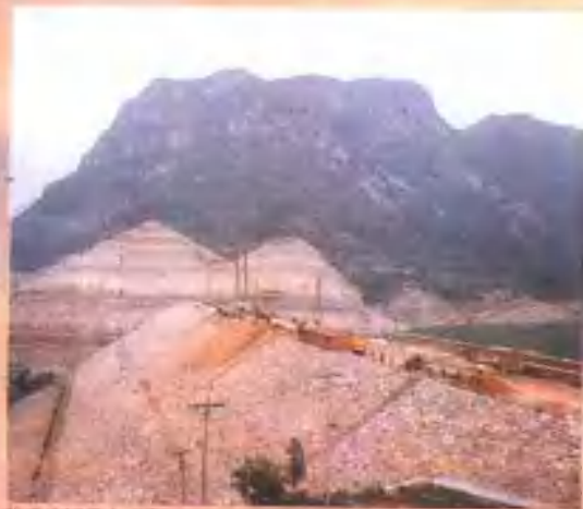
施工中的马上水库
