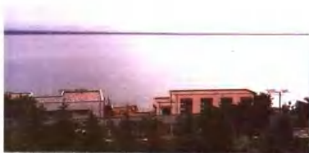
从水库日抽 2.0 万吨水的白龟山水厂泵房
