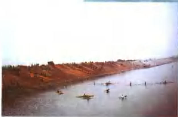
水库大坝除险加固工程正在紧张施工
