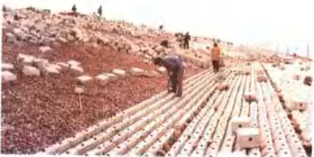
水库除险加固工程施工
