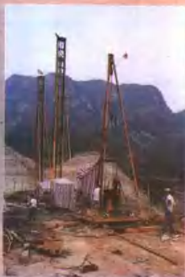
马上水库除险加固工程高压喷射灌浆施工
