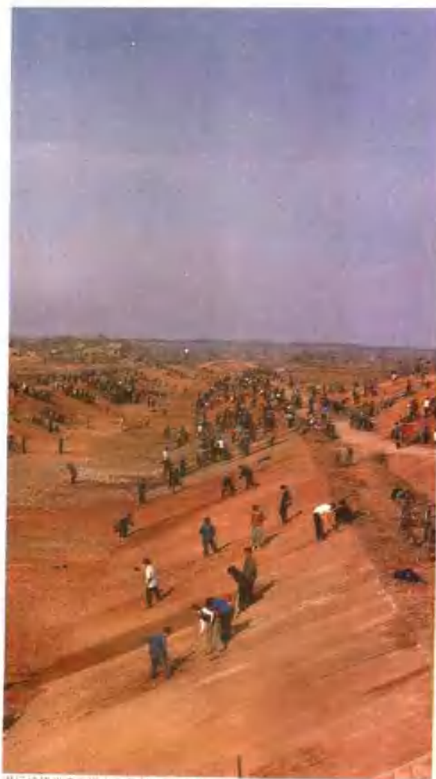
灌区续建配套工程中干渠1997年冬修施工现场
