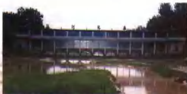
黄河新庄水闸
