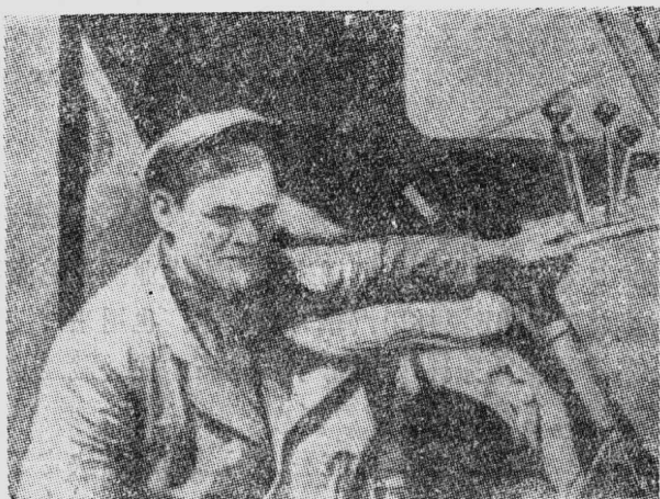
新達哈諾夫挖土機手Д.К.吉吉克和他的Э-505型挖土機
