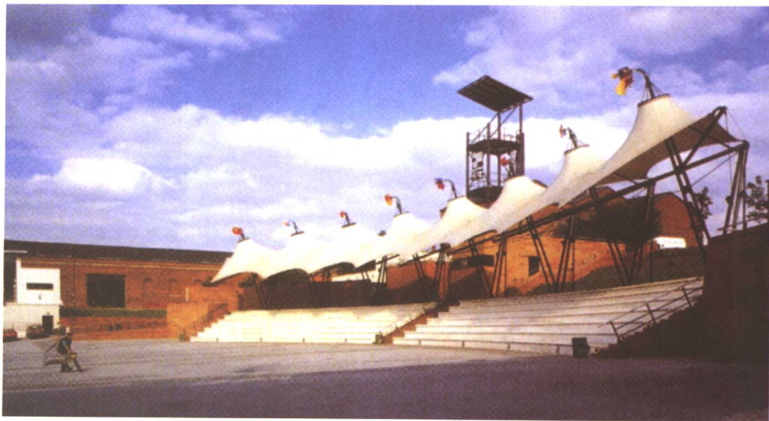
图8 索膜结构以其结构轻盈、造型多样等优点,近年来受到人们的青睐。
