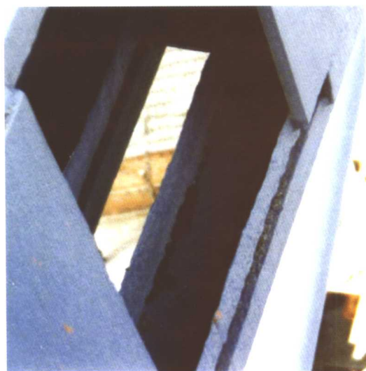
图 3.10.1 平台梁翼缘锈蚀 (123 页)
