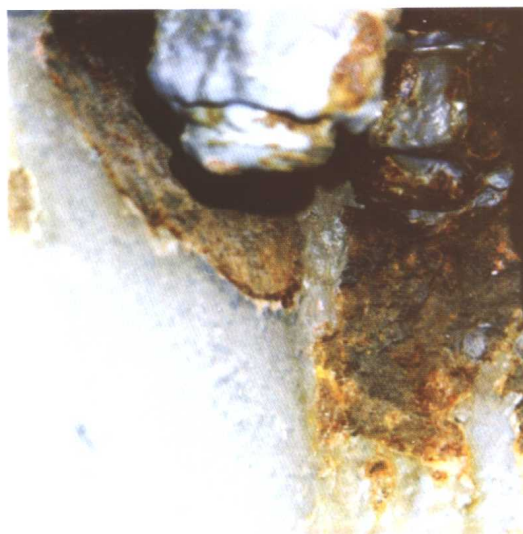
图 3.10.2 背阴处的螺栓头或螺母都锈蚀较重 (123 页)
