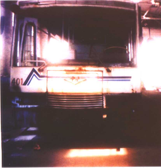
图 3.8.1 车灯框、进气栅板、车前面板的腐蚀 (115 页)
