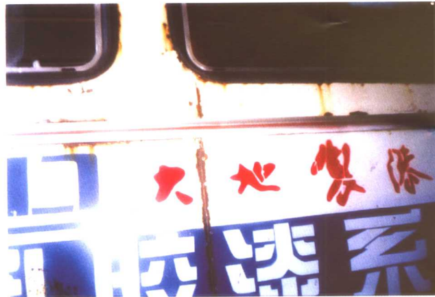
图 3.8.3 车面板、车面板连接处、车窗框的腐蚀 (115 页)
