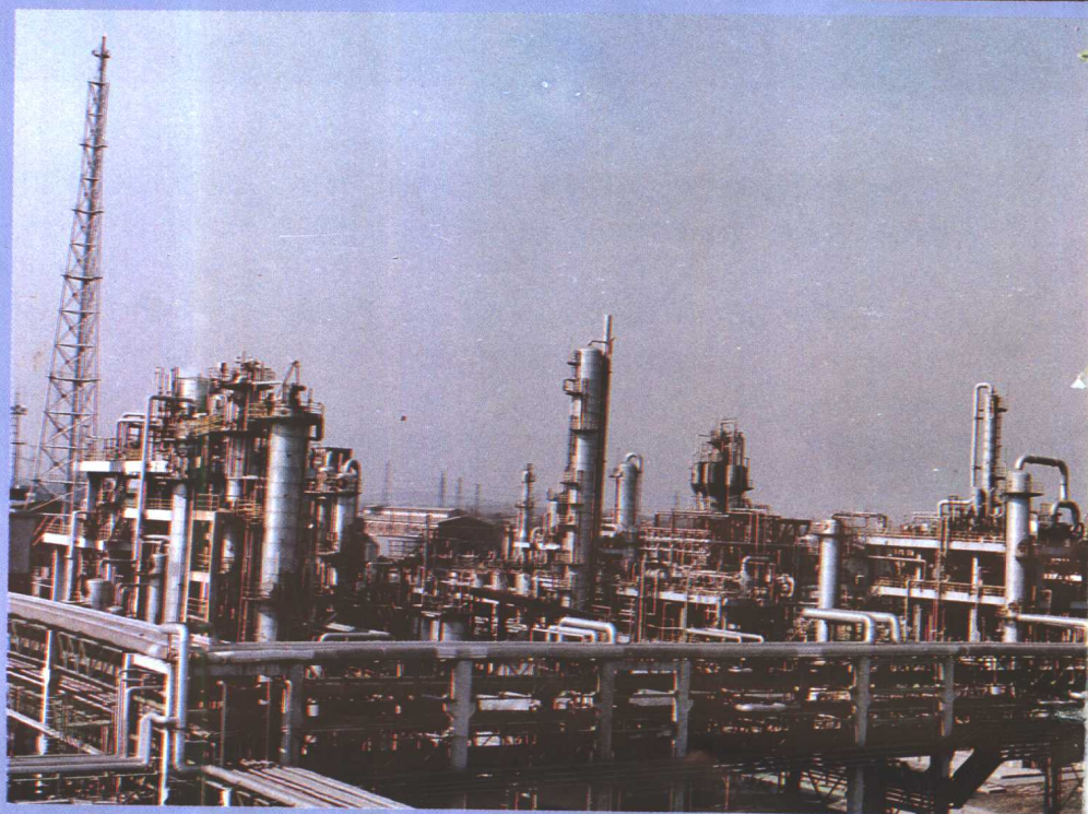
年产 5 万吨己内酰胺工厂(上) 现代化己内酰胺工厂装置一角(下)
