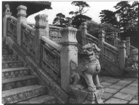
▲隆恩殿台基，栏杆石雕
