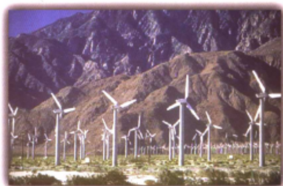
▲ 现代风力发电站
