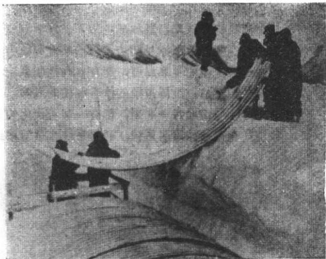
圖3 工程人員正在安放鋼板。
