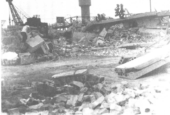
►唐山火车站候车大楼倒塌。
