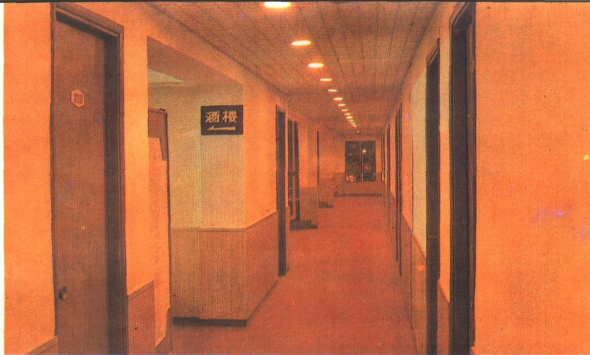
图 5-22 走廊照明实例
