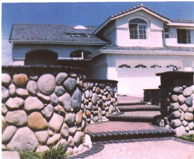
彩图 9 卵石砌筑的墙体、柱面
