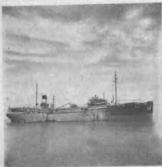
← 自航式「建設號」挖泥船
