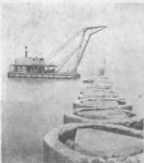
→ 起重船「泰山五號」正在修建防波堤
