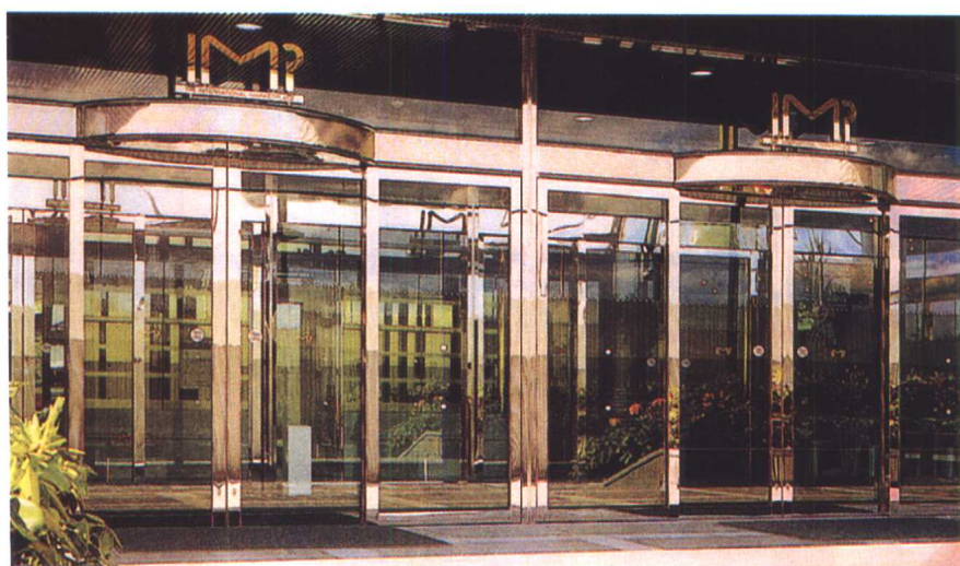
平开式电动门 (对开、上置式液压开门机)
