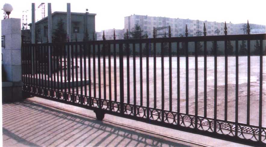
滑轨电动门(单 轨、单开、带矛头、高 1.8m)
