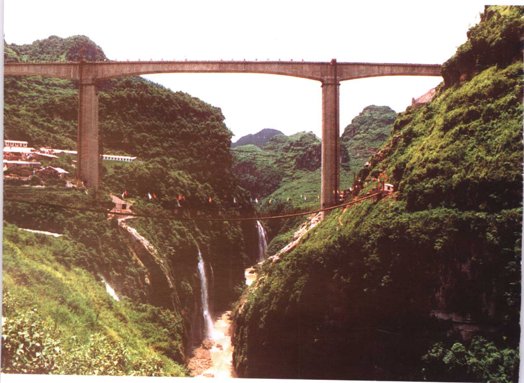
世界第一高桥——清水河大桥
