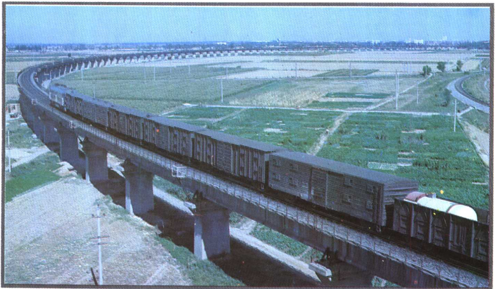
铁路编组站至东良政铁路高架桥(俗称百孔桥)
