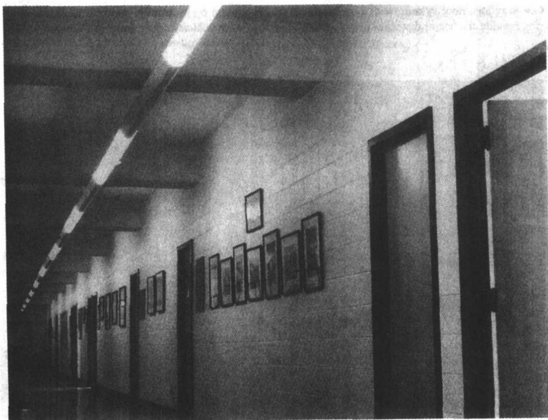
图 1.1 整浇梁支承的单向钢筋混凝土楼板
