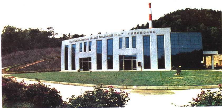
处理医疗废物的广东生活环境无害化处理中心
