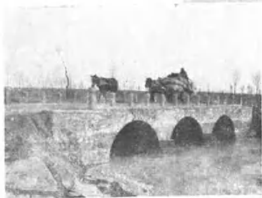
左 河北藁县农民用砖修的 拱桥。
