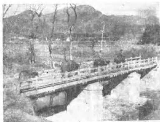
左 浙江临安县农民修的石 台木面桥。
