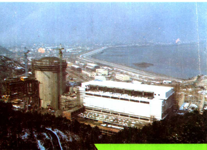
秦山核电站全景
