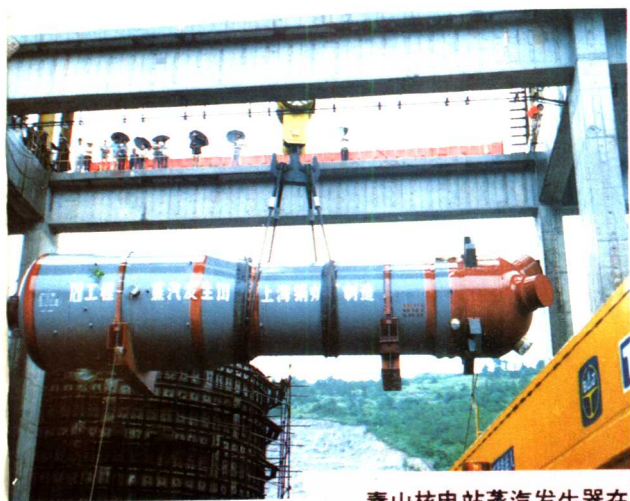
秦山核电站蒸汽发生器在吊装中
