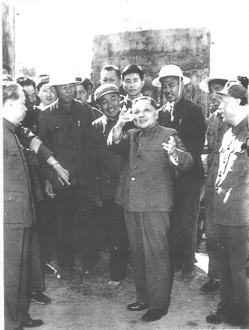
◀ 一九八七年九月十九日邓小平同志视察唐山住宅建设工地
