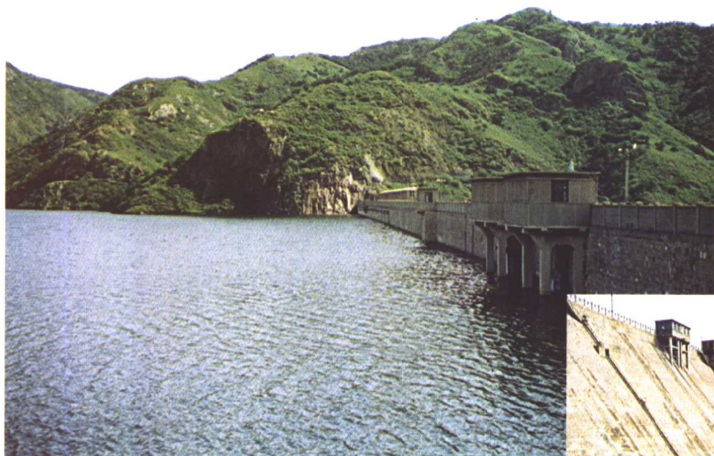
1975年建石河水库坝前进水口
