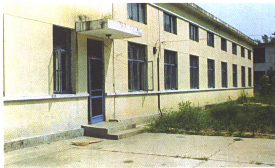
1984年建北戴河（沙窝）中途加压站
