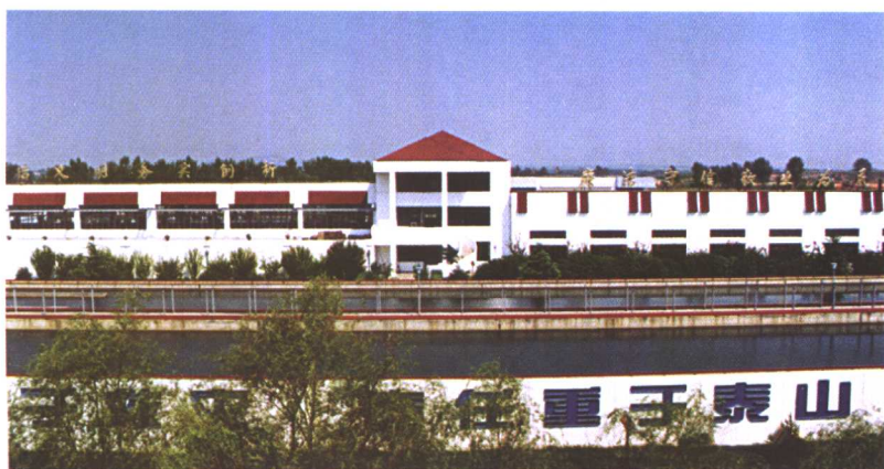
1990年6月竣工崔各庄水厂生产车间及平流沉淀池
