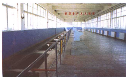
1990年6月竣工崔各庄水厂滤站操作室
