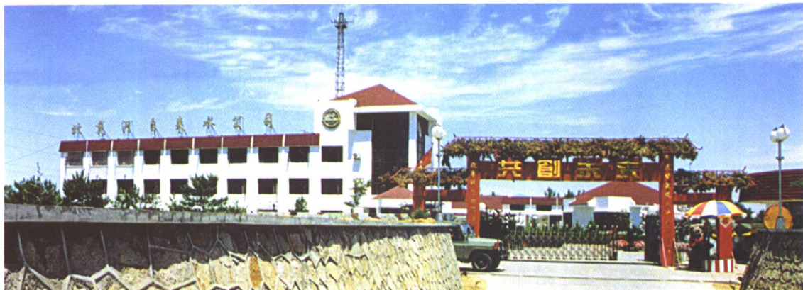
1990年6月竣工北戴河自来水公司办公楼及改建后门卫（崔各庄水厂）
