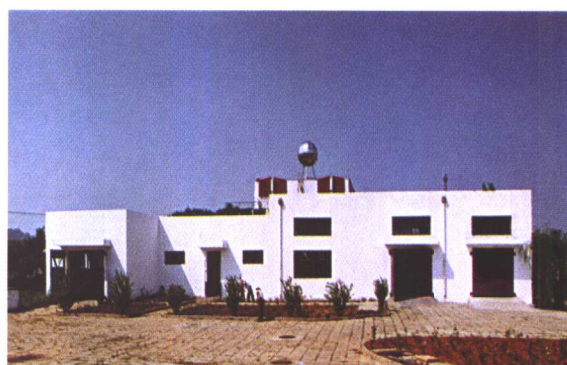
1990年6月竣工崔各庄水厂加氯加药间建筑
