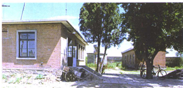
1964年建枣园水源地加压泵站及值班室
