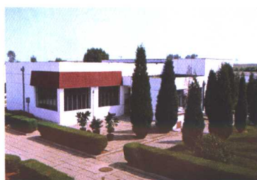
1990年6月竣工崔各庄水厂进水泵房
