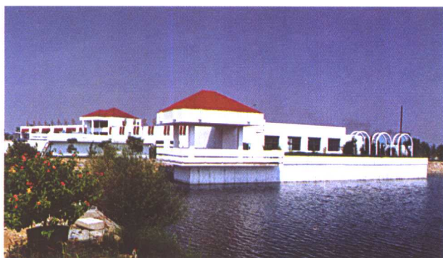
1990年6月竣工北戴河崔各庄水厂事故水池
