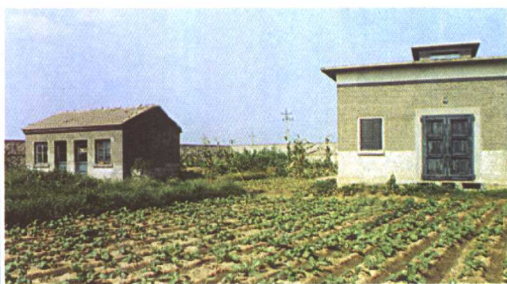
1958年建枣园水源地变电室及值班室
