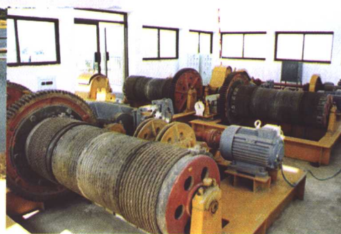
洋河水库进水塔进水总闸
