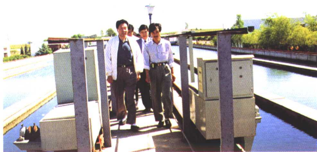
市城建局长聂春友、副局长李永臣 到北戴河自来水公司现场办公 (视察平流池)
