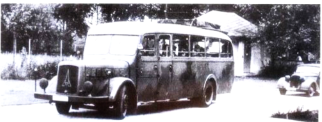
▲ Magirus公司在三轴M206卡车基础上改装的Kfz 261无线通讯车，本车的生产周期从1934年到1937年，车辆迷彩同样为德国魏玛共和国陆军（Reichswehr）的标准的涂装
