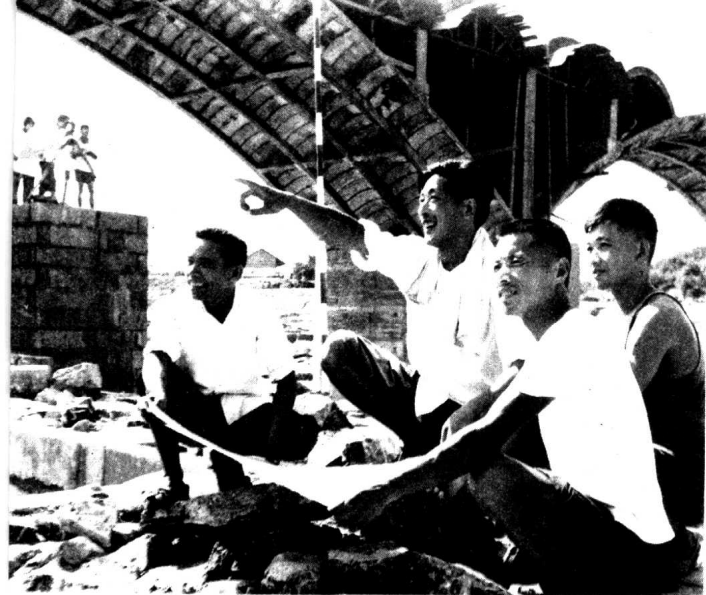
“三结合”小组狠抓施工质量
