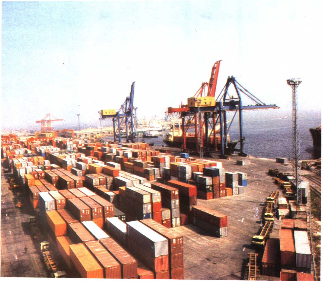
天津港集装箱码头 Tianjin Port: The container terminal
