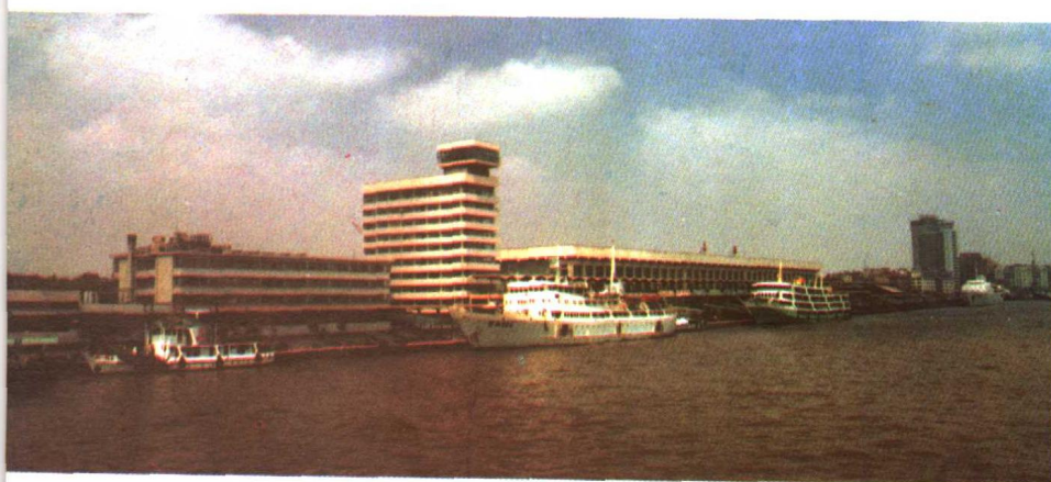
上海港十六铺客运码头 Shanghai Port: The Shiliupu Passenger terminal
