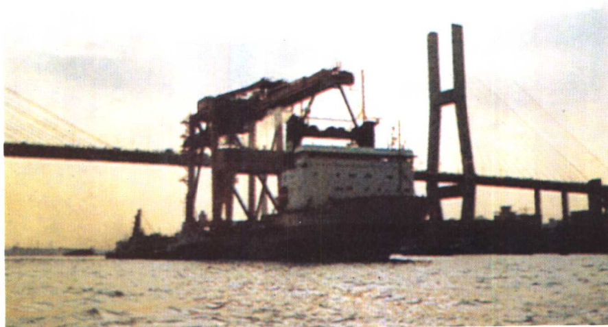
引航通过南浦大桥
