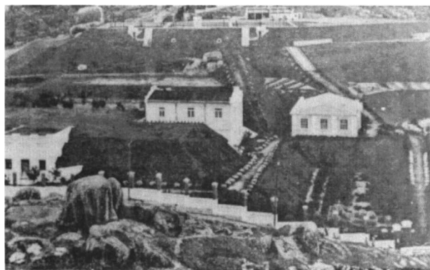
厦门自来水 公司设在上李 (上里)赤岭的滤 水池
