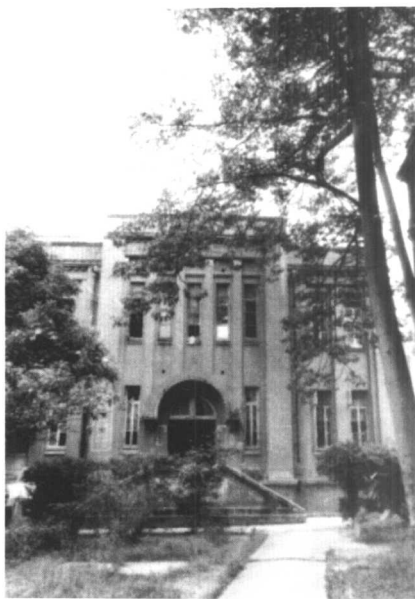
1928年，日本在驻厦门领事馆内建造的警察署，其地下室设有刑讯室和监狱。
