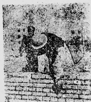
图 10 用两用大镜构立缝
