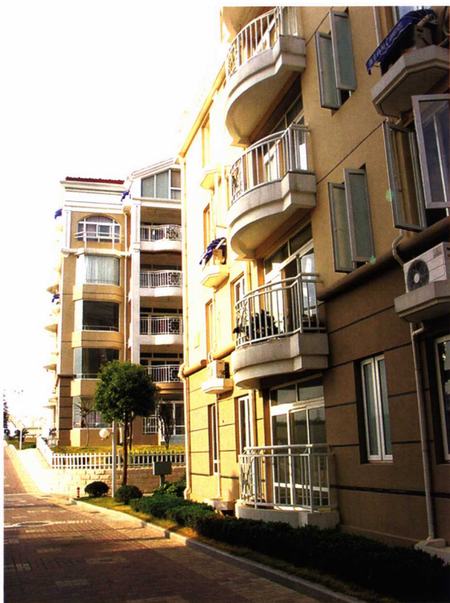
弧形的凸出阳台,造型非常美观
