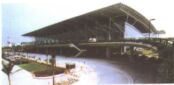
深圳机场新航站楼
