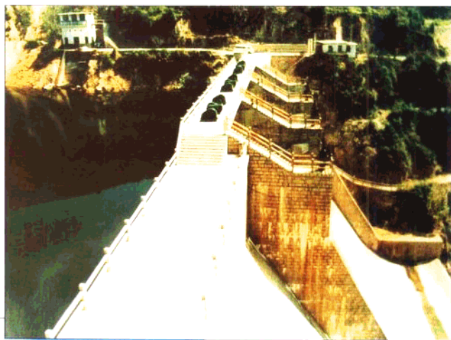
松溪县茶州水库浆砌石空腹重力坝—— 获1989年福建省科技进步三等奖
