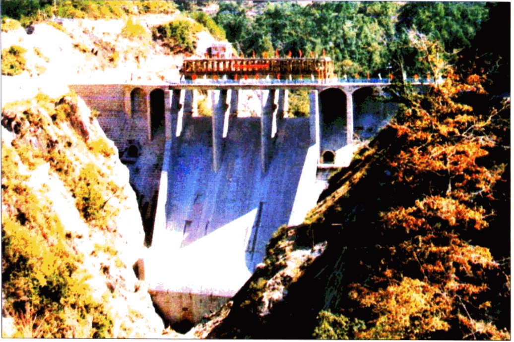
大田县坑口水库碾压混凝土坝——获1988年国家科技进步一等奖
