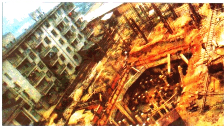
射水法建造地下混凝土连续防渗墙在工民建深基坑开挖中的应用
