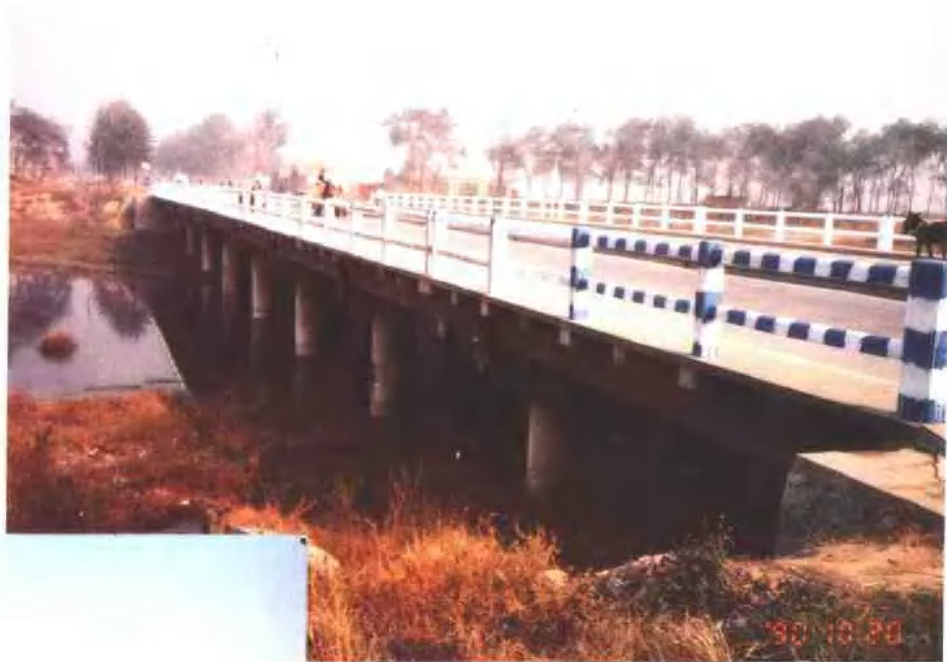
跨龙河于常甫交通桥
