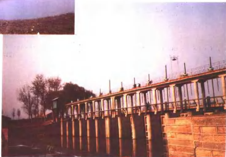
跨龙河水丰拦蓄闸
