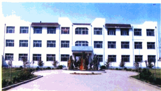
1997年，新落成的盲聋哑学校教学楼
