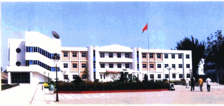
晋州市第一中学科技楼
