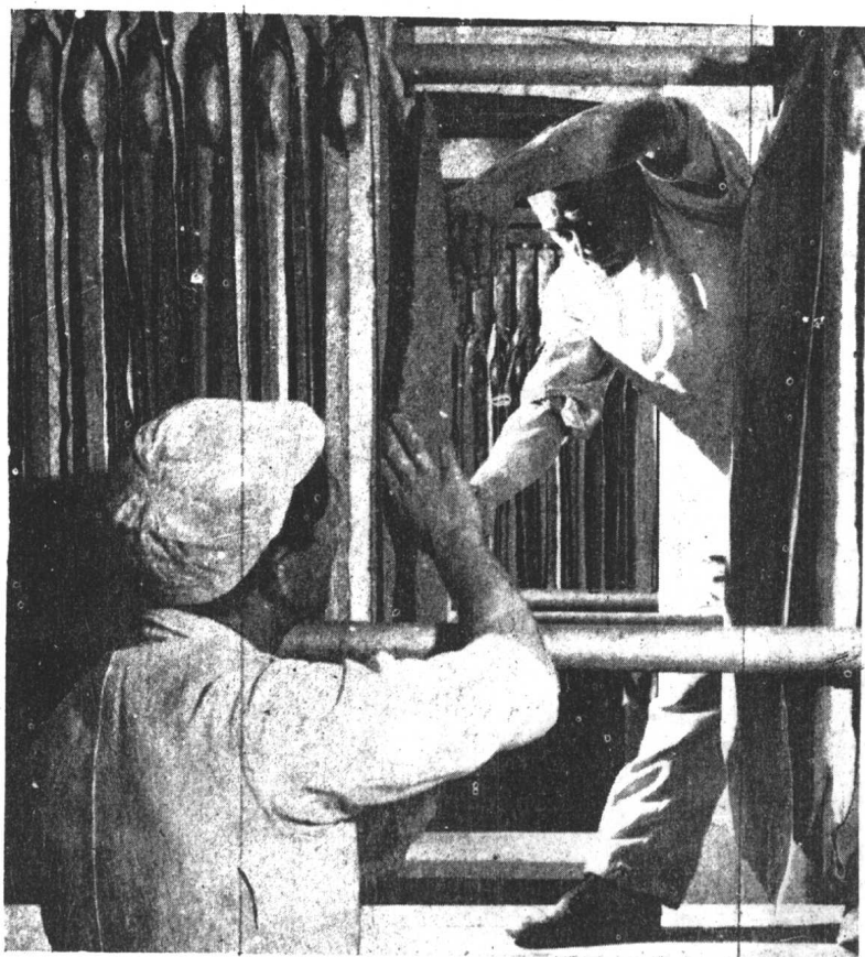
圖片 1. 榨濾機之卸榨濾餅。
