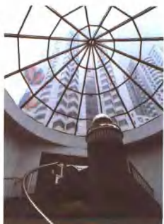
从楼梯看主楼
