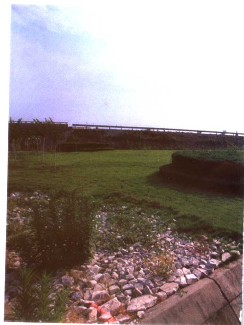
互通区绿化景观及排水沟
