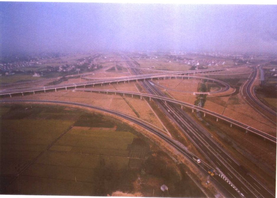
与沪杭高速相交的大型枢纽
