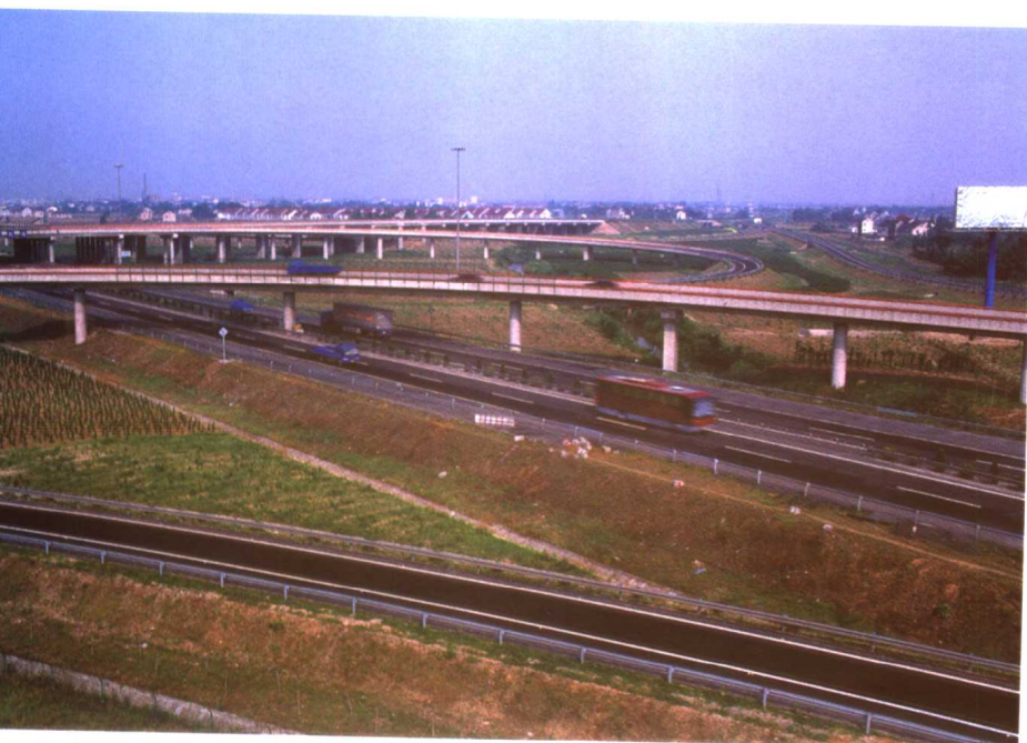
枢纽区域跨线桥
