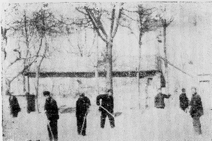
圖 2：在陽光下場內晒水泥原料——白堊土、紅粘土無烟煤。
