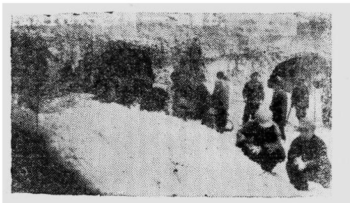
圖 1：在山坡上挖水泥原料——白堊土
