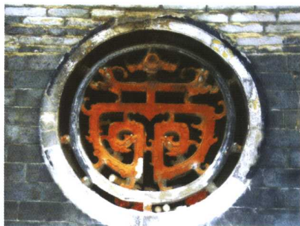
连城芷溪客家民居建筑上的漏窗装饰，精美异常
