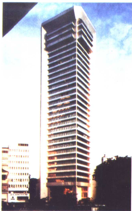
马来西亚吉隆坡光前大厦。
