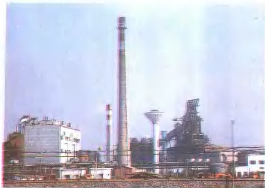
唐山钢铁公司(第二炼铁厂高炉)
