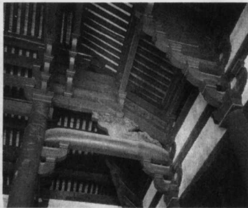
▲大殿次间东北角构架
