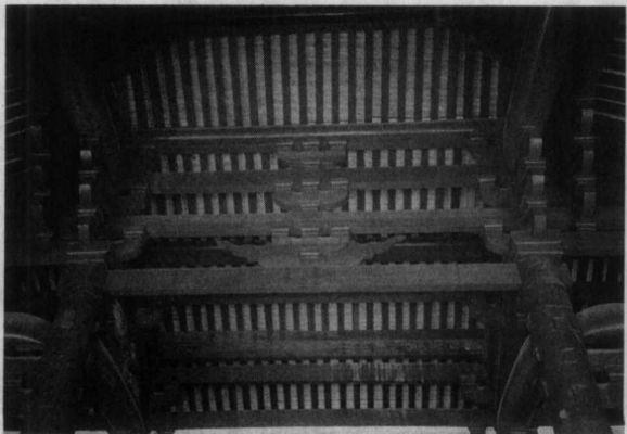
▲大殿明间梁枋上的云形驼峰
