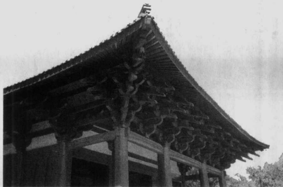
▲大殿前檐铺作结构
