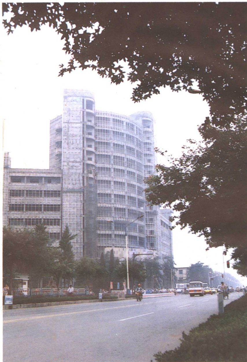
▲正在建设中的秦皇岛市邮电大楼
