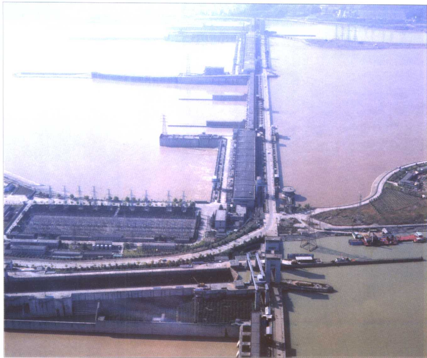
葛洲坝水利枢纽工程
