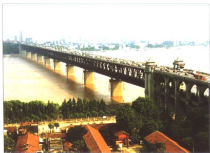
武汉长江大桥
