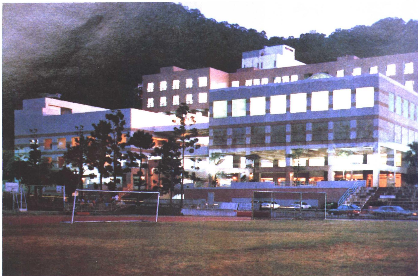
图二十三 台湾东吴大学综合大楼新建工程
