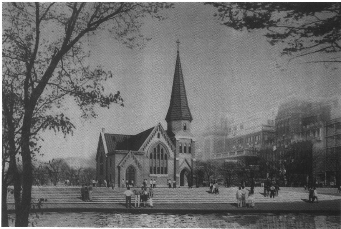
“外滩源”主景之一——新天安堂，又称联合教堂。建于1886年，由英国建筑师设计，为哥特复兴风格，后遭改建并局部破坏。2001年由常青研究室根据历史资料复原，将成为上海市风貌建设重点工程“外滩源”滨水（苏州河）景观中的观点，可能用作音乐堂或博物馆。
