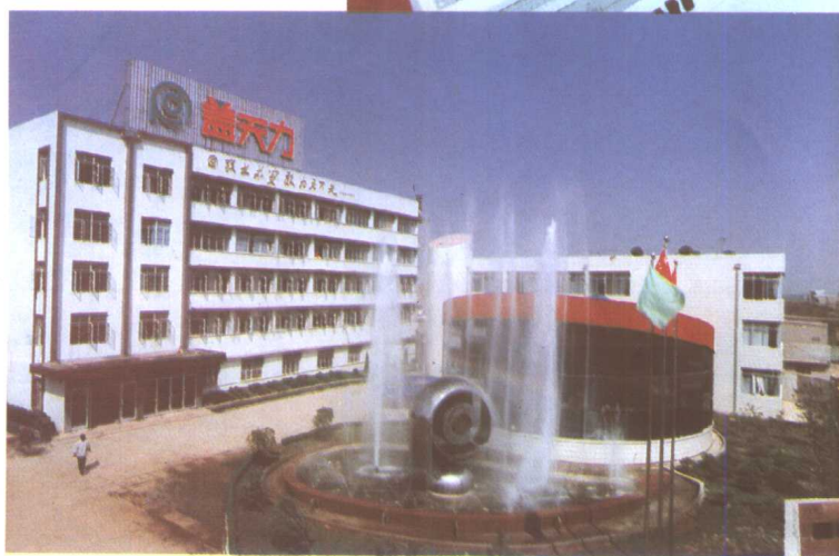
公司质量管理大楼全景
