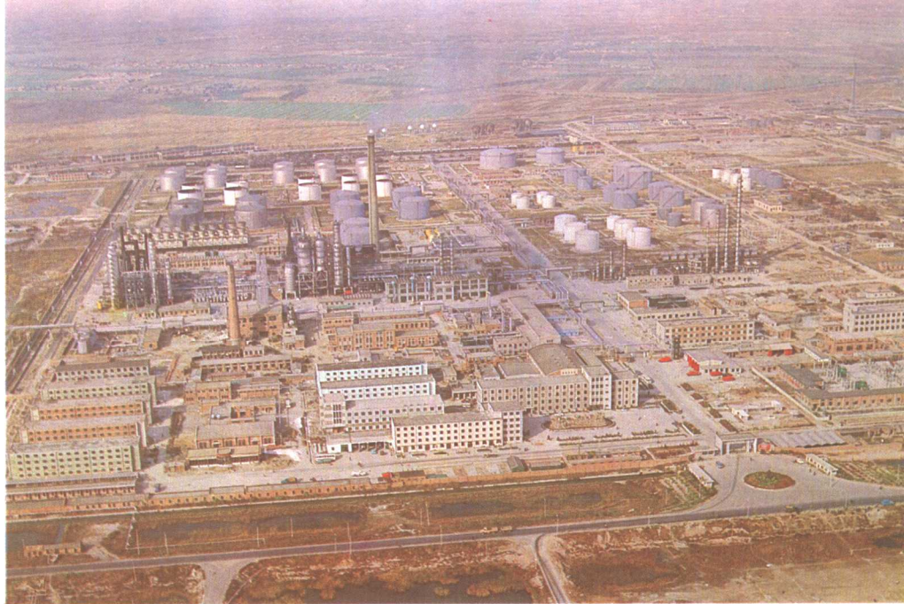
天津石油化工公司炼油厂
