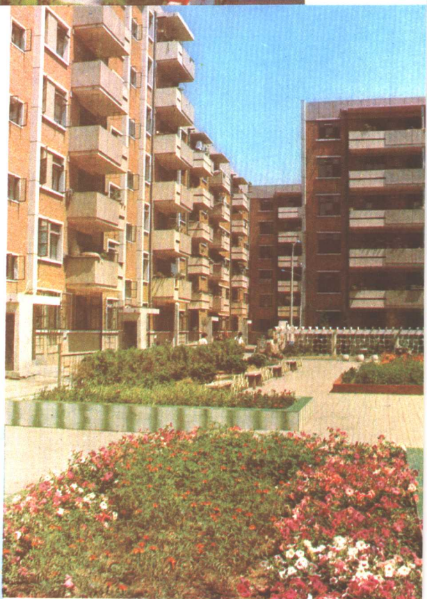
三级跳坑改造后的住宅楼
