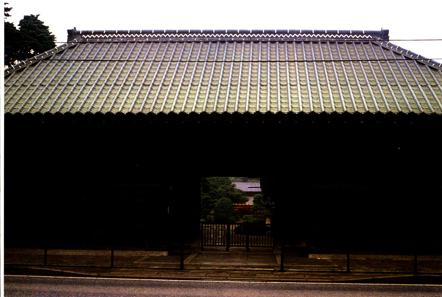
宏大的农家条形住宅的宅门。现在均改为用马口铁皮铺顶。使人感受到宽大的空间比例。
