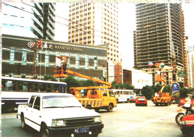
工人在整修路灯线路
