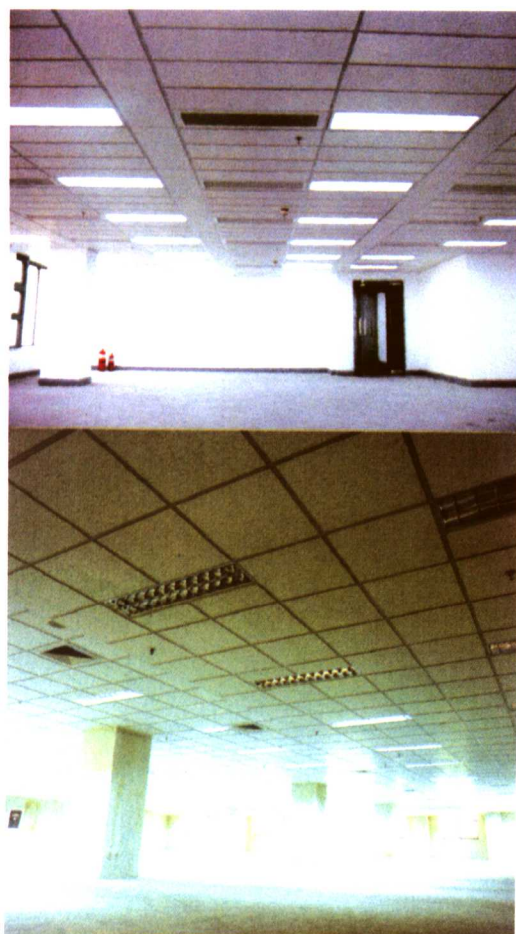
烤漆龙骨配合明架矿棉板使用工程实例
